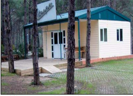
Şekil 4.6.Vespa binası; kuzeydoğu cephesi
