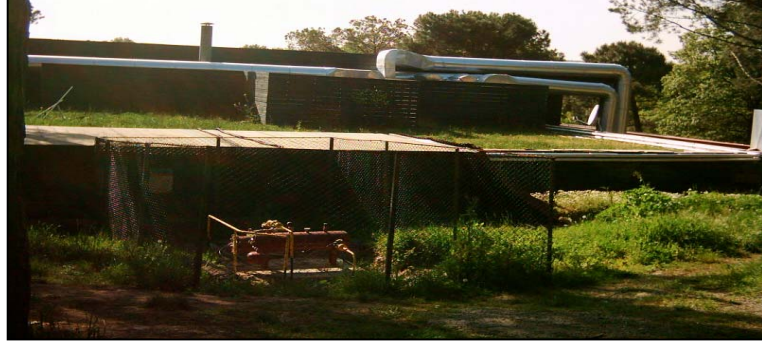
Şekil 4.9. Party Kids binası; arka cephe
