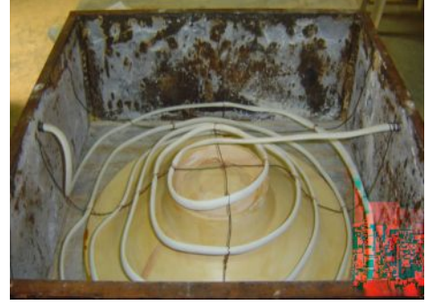
Resim: 18 Hava tesisatının son hali
