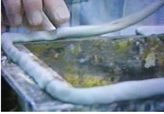
Resim: 108 Çerçeveye çamur yerleştirilmesi
