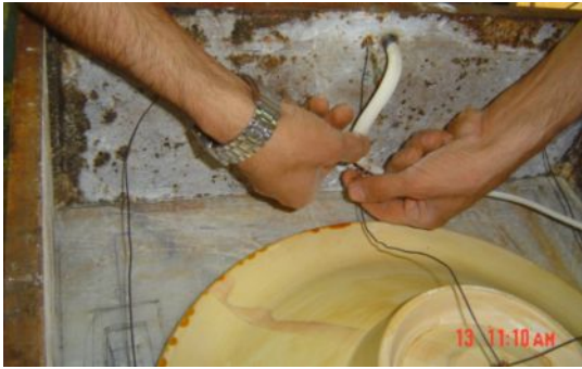
Resim: 15 Hortumun iskeleye döşenmesi
