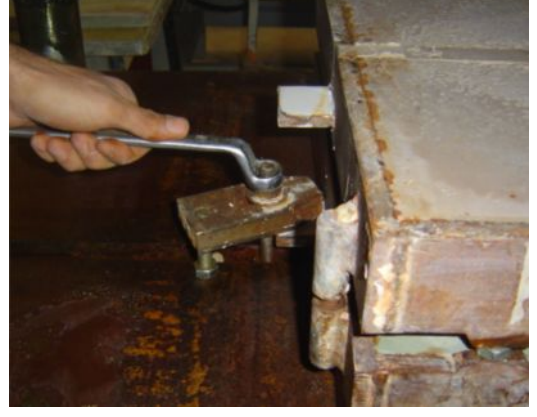
Resim:94 Bağlantı elemanlarının sökülmesi
