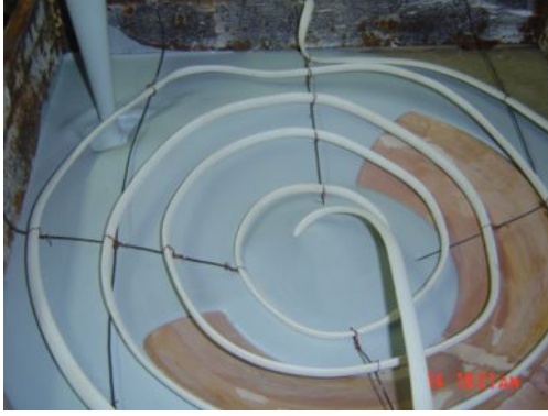
Resim: 28 Alçının dökülmesi
