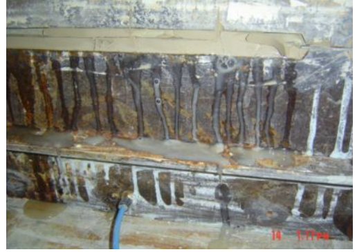
Resim: 29 Kalıba hava verilmesi
