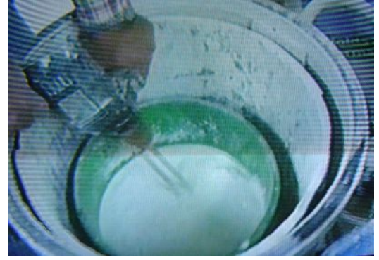
Resim: 109 Alçının manuel karıştırılması
