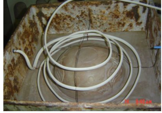
Resim:48 Makaronun döşenmesi
