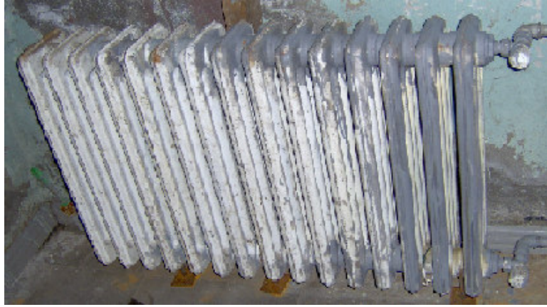
Şekil 5.3 Deney setinde kullanılan radyatör dilimleri ve bağlantıları.
