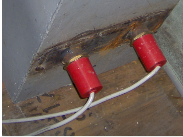
Şekil 5.6 Elektrikli su ısıtıcılarının depoya monte edilişi.
