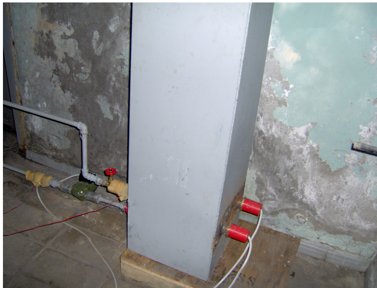
Şekil 5.2 Sıcak su deposu ve bağlantı elemanları.
