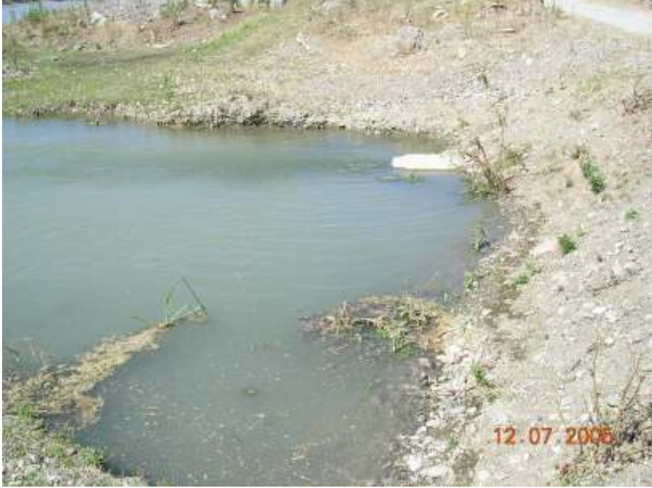
Resim 5.1. Bafra Atıksu Arıtma Tesisinin sularının deşarj edildiği nokta) (9 nolu numune noktası)
