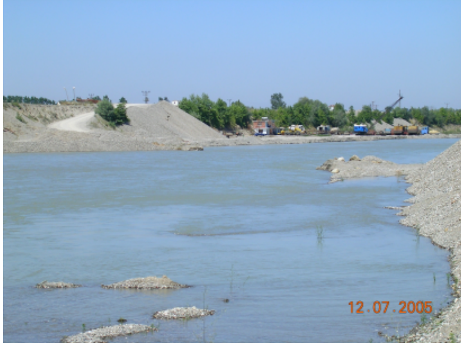
Resim 2.3. Kızılırmak Yatağındaki Malzemeyi Kullanan Beton-İnşaat Şantiyelerinden Biri
