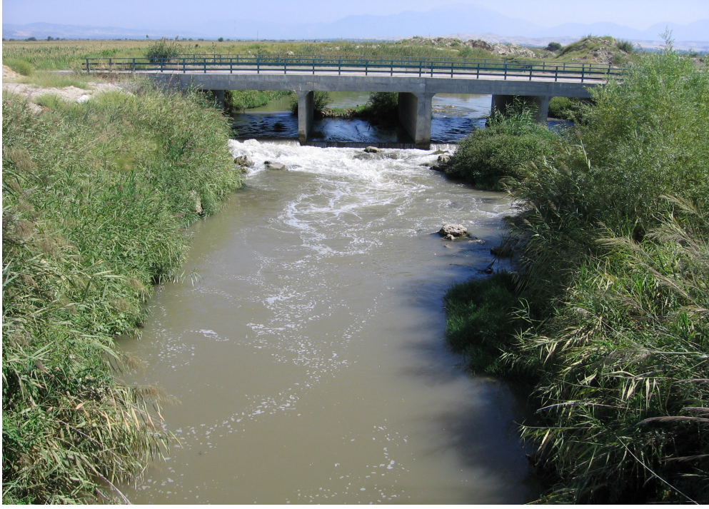
Şekil 3.9 V.İstasyon ( Çürüksu, Büyük Menderes’e karışmadan önce, Sığma Köprüsü )
