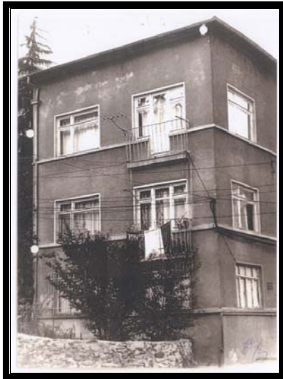
Resim 3.48. 164 ada, 14 parselde bitişik bina.
