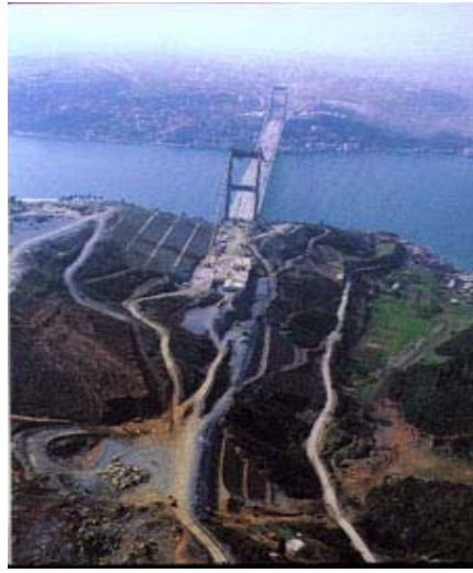
Resim 2.27. Fatih Sultan Mehmed Köprüsü'nün yapımı.
