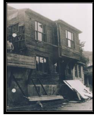
Resim 3.53. Ahşap yapının eski fotoğrafı.
