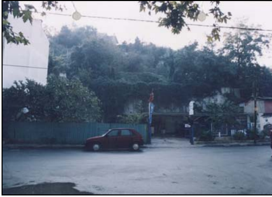
Resim 3.52. 961 ada, 116 parsele ait fotoğraf.
