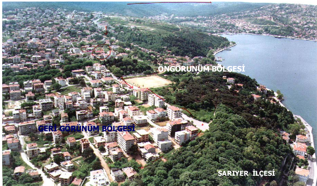
Resim 3.21. Sarıyer'deki Öngörünüm Geri Görünüm Alanı.
