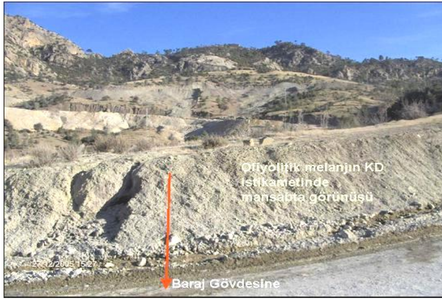
Şekil 3.8. Baraj mansabında sağ sahil enjeksiyon perdesinin bağlandığı ofiyolitik melanj birimi
