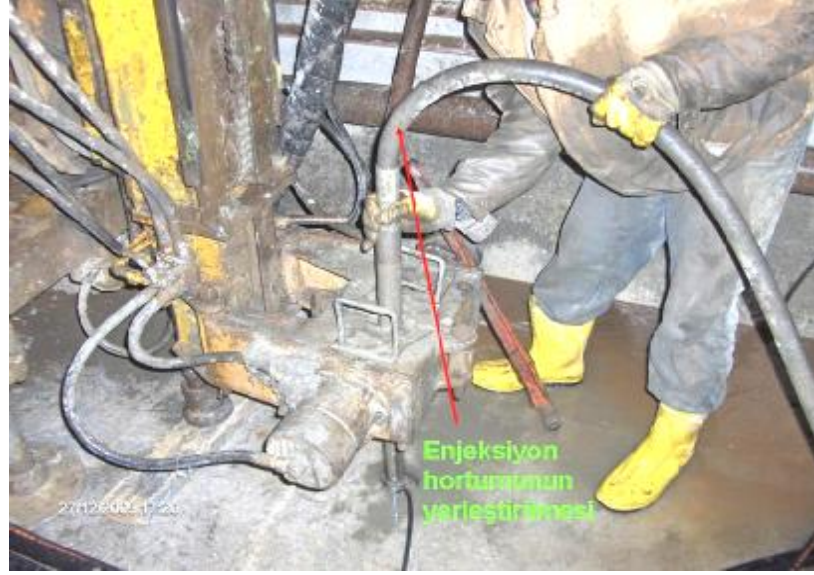
Şekil 3.16. Enjeksiyon hortumunun yerleştirilmesi
