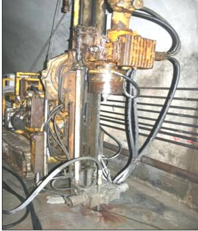
Şekil 3.10. Perde enjeksiyon kuyusunda enjeksiyon yapılırken (Wirth)
