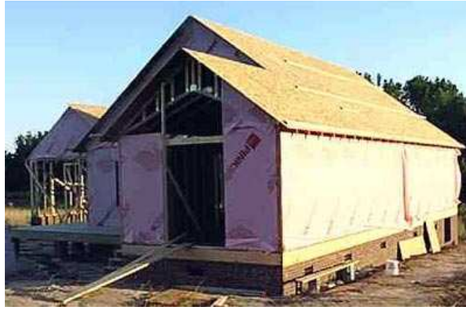
Resim 4.17. OSB çatı kaplaması örneği 1 (162)
