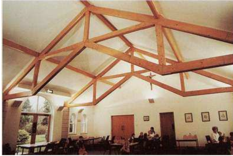
Resim 4.39. Ashton, Makefield'de bir kilisede LVL çatı makası (191)
