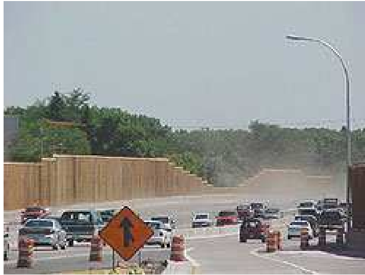
Resim 4.66. Otoyolda ses bariyeri olarak tutkallı lamine ahşap malzemenin kullanılması
