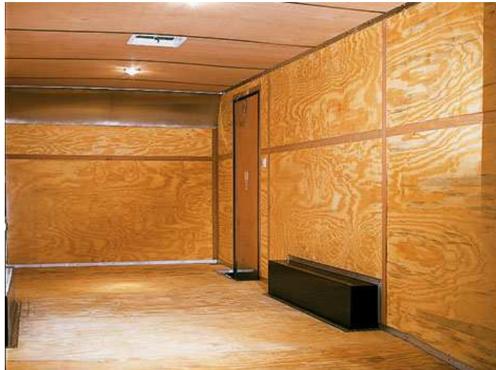
Resim 4.7. Kontrplak duvar kaplaması ve döşeme (166)
