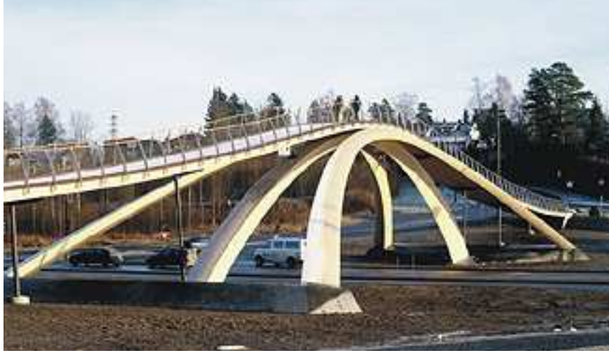
Resim 4.77. Leonardo köprüsü genel görünüm (192)
