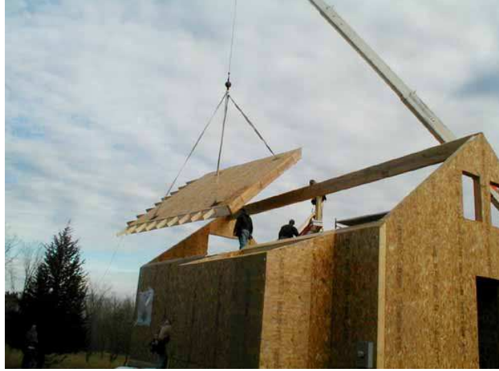
Resim 4.34. OSB'den üretilmiş sandviç panellerin vinç yardımıyla yapıya oturtulması (182)
