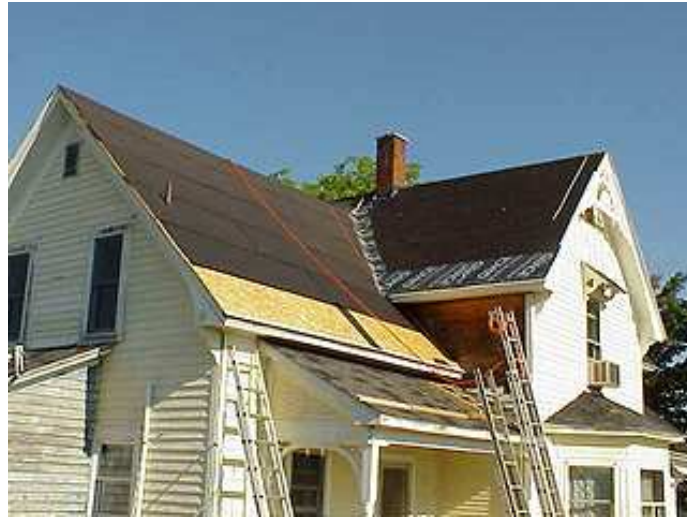
Resim 4.18. OSB çatı kaplaması örneği 2 (161)
