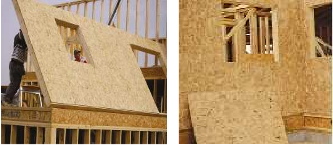
Resim 4.29. ve 4.30. Duvar pano olarak OSB (184)
