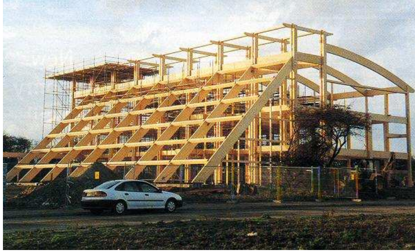
Resim 4.37. Tutkallı lamine ahşap malzeme ile yapı iskeletinin oluşturulması (150)
