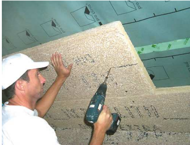
Resim 4.35. Talaş levhanın uygulaması (155)
