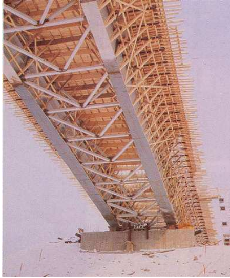
Resim 4.81. Finlandiya’da köprü yapımında kalıp olarak LVL malzemenin kullanılması (191)
