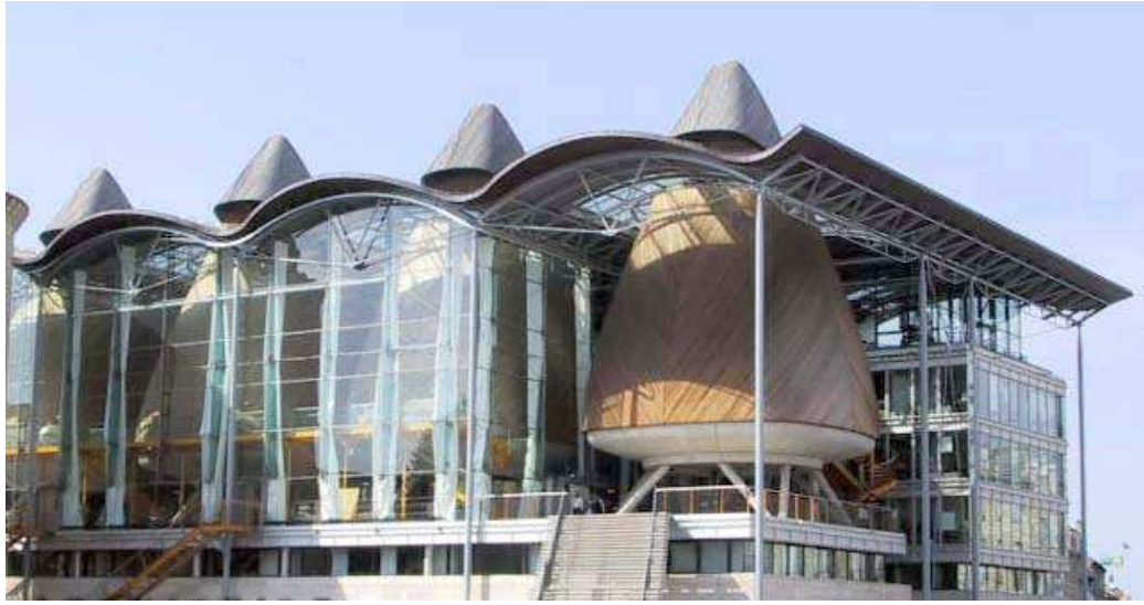
Resim 4.22. TGI binası girişi (141)
