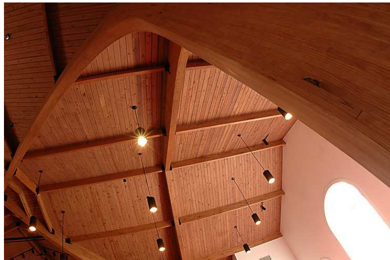
Resim 4.15. Mountain View Methodist Klisesi tutkallı lamine ahşap tavan kaplaması (174)
