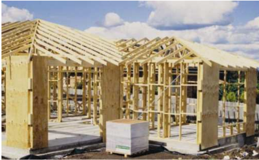
Resim 4.43. Yapı iskeletinin kontrplak ile oluşturulması
