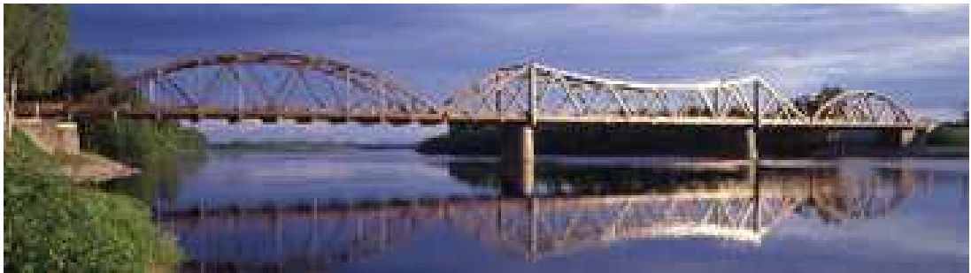
Resim 4.79. Flisa Köprüsü, Norveç
