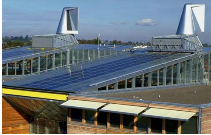
Resim Ek-C-5.1. Jubilee kampüsü atriumda PV modül uygulaması ( www.iea-pvps.org )
