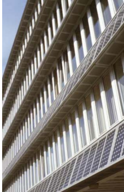
Resim Ek-C-4.2 Northumbria Üniversitesi- cephede PV yağmur perdeleme sistemi uygulaması ( www.iea-pvps.org )
