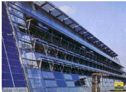
Resim Ek-C-2.1. Solar fabrik binası hareketli PV modüller (www.iea-pvps.org)
