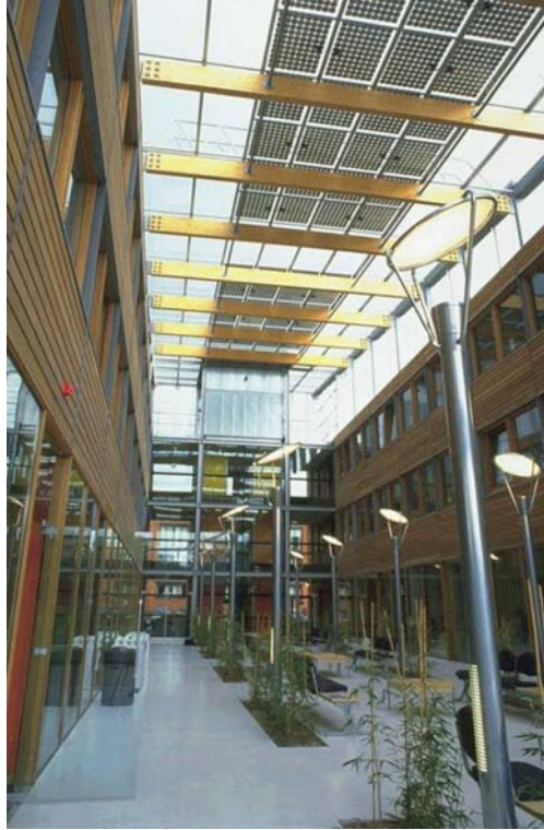
Resim Ek-C-5.2. Jubilee Kampüsü'nde PV uygulanmış atriumun içten görünümü ( www.iea-pvps.org )
