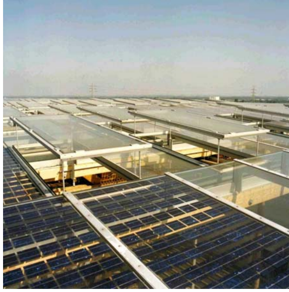
Resim Ek-C-1.2. Mont-Cenis akademisinin çatıdan doğal havalandırılması ( www.pvdatabase.com )
