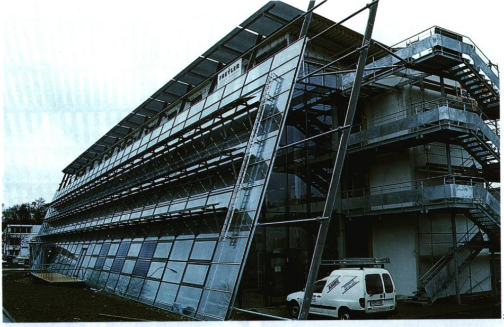
Resim Ek-C-2.2. Solar Fabrik binası eğimli cephede PV modül uygulaması (Göksal 2003)
