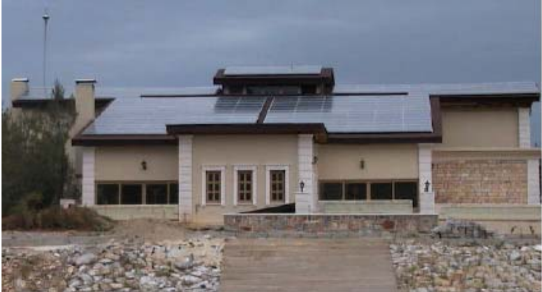
Resim Ek-B-1.2. Çatısı 25.6kWp fotovoltaiik sistemle kaplı bulunan Türk Evi öğrenci kafeteryası (Oktik ve diğ. 2005)
