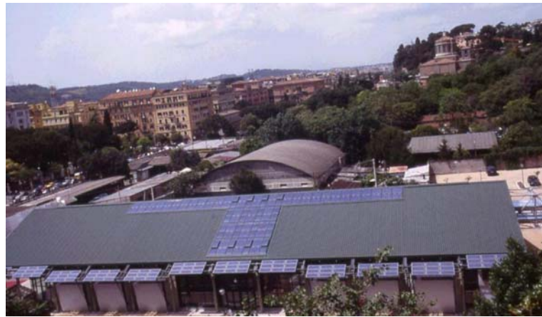
Resim Ek-C-3.3. Roma Çocuk Müzesinin çatısında PV modül uygulaması ( www.pvdatabase.com )
