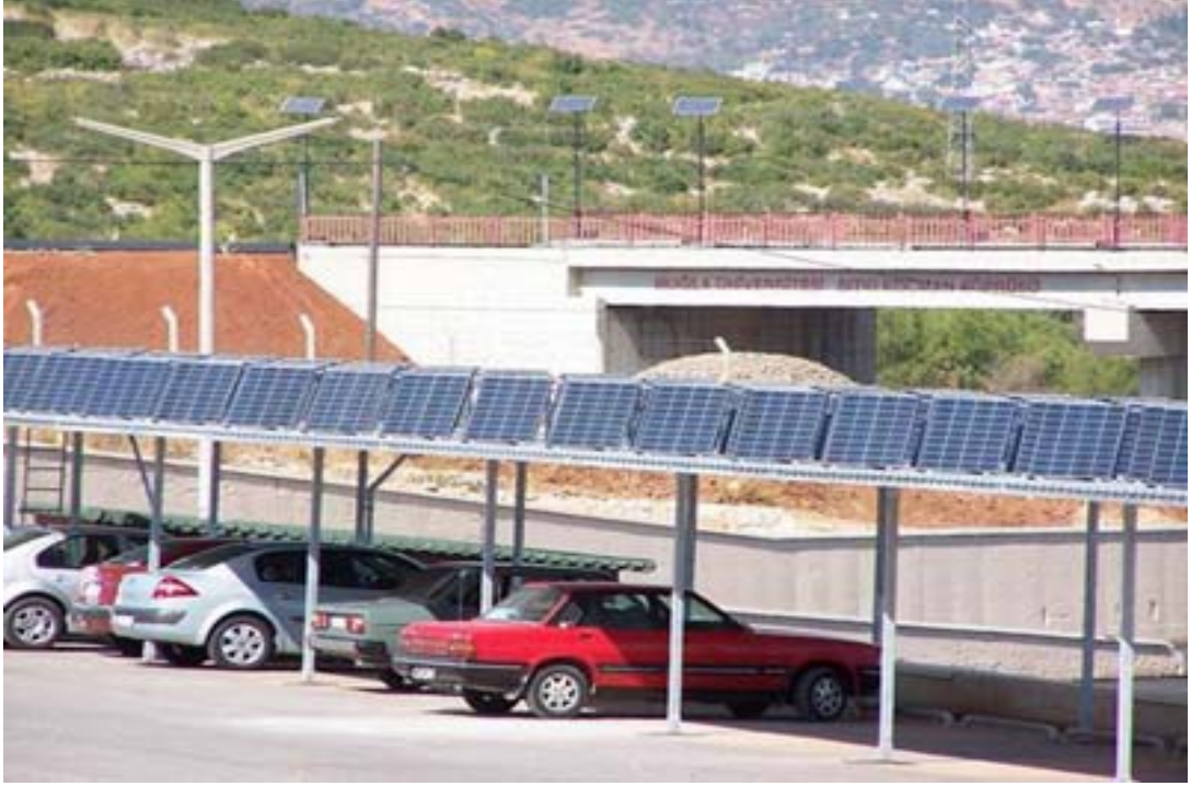
Resim Ek-B-1.3. Otopark alanı üzerindeki 15kWp güce sahip hibrit sistem (Oktik ve diğ. 2005)
