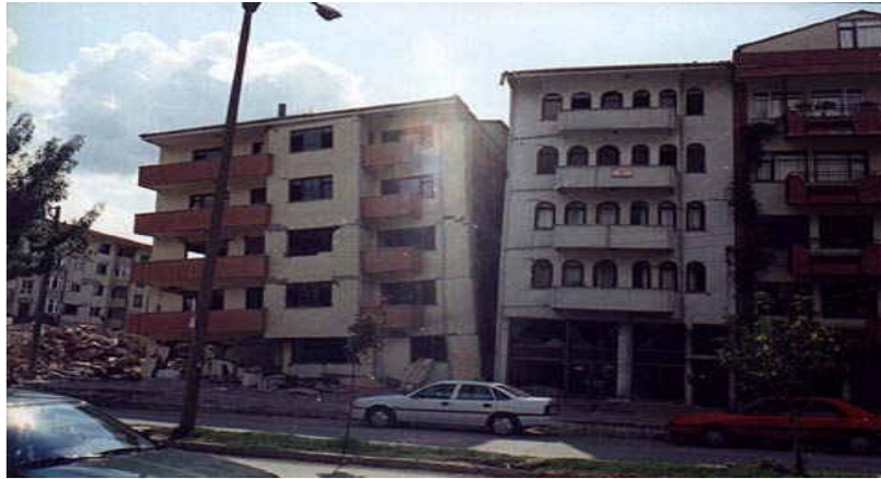
Şekil 2.8 17 Ağustos Sakarya Depreminde Bitişik Nizam Düzeninde Yapılmış Binalar (Sakarya Valiliği Devlet Arşivi, 1999)
