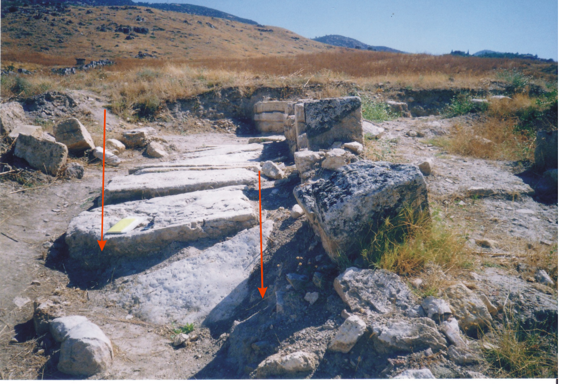
Şekil 24. Şehir Caddelerinde depremlerden dolayı oluşmuş deformasyonun görünümü.
