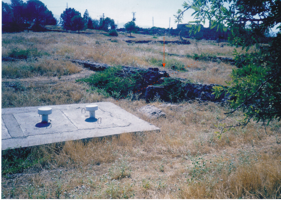
Şekil 17. Şehrin güneyindeki traverten kanallarındaki çatlaklardan bir görünüm (Oklar kırığı gösterilmektedir.).
