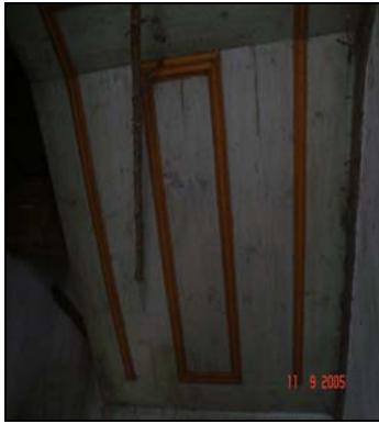
Resim 6.3. B06 mekanlardaki merdiven altı kaplamaları
