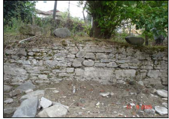
Resim 5.4. Konağı'ndaki bahçe duvarı
