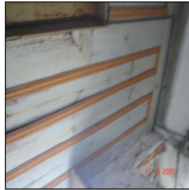
Resim 6.4. Çıtaların Bağdadi duvar ucundaki bitim şekli
