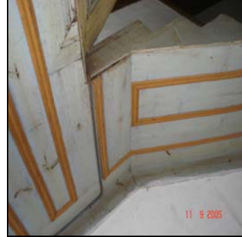
Resim 6.2. B01 mekanlardaki tavan kaplamaları
