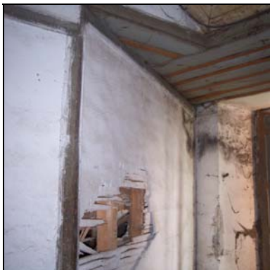
Resim 6.5. Özgün duvarda çıta bitim şekli
