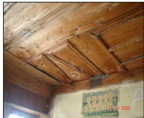
Resim 6.6. Z14 nolu tavan kaplaması
