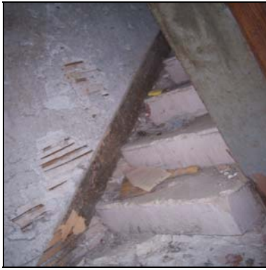
Resim 6.9. B06 nolu mekanlardaki taş merdivenler
