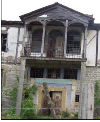
Resim 4.5. Batı cephesindeki balkon
