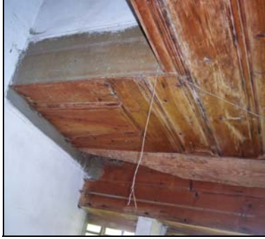
Resim 6.7. Z14 nolu tavan kaplaması ve merdiven sahanlığından
