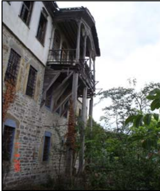
Resim 4.9. Kuzey cephesindeki balkon
