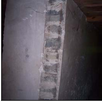
Resim 6.1. Kaldırılan kapının kasa izi (B01 nolu mekandan)
