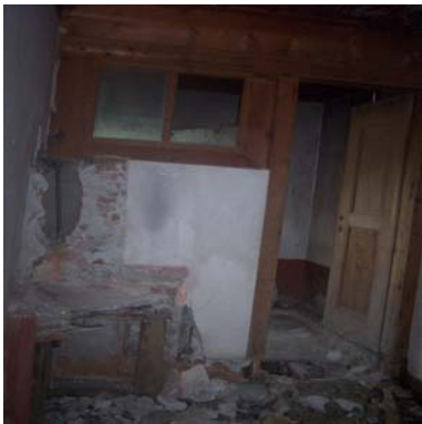
Resim 5.31. Kitaplı konağındaki lavabo
