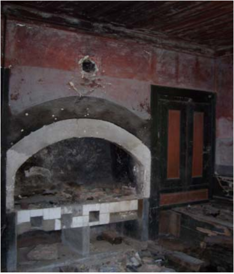
Resim 5.9. Kitaplı Konağı'nın mutfağı, (Z10) nolu mekan
