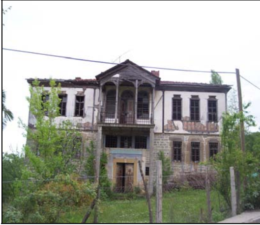
Resim 4.3. Kitaplı Konağı'nın batı cephesi
