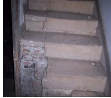
Resim 6.8. B01 nolu mekanlardaki taş merdivenler
