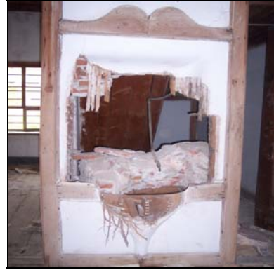
Resim 5.30. Kitaplı konağındaki lavabo
