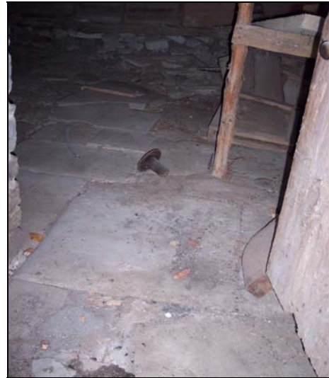
Resim 5.10. İncelenen yapılarıdaki soğukluk döşemesi
