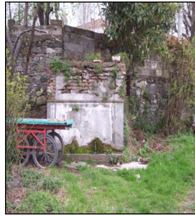
Resim 3.4. Çeşme Mah. Koymat Sok. 12 nolu parseldeki çeşme
