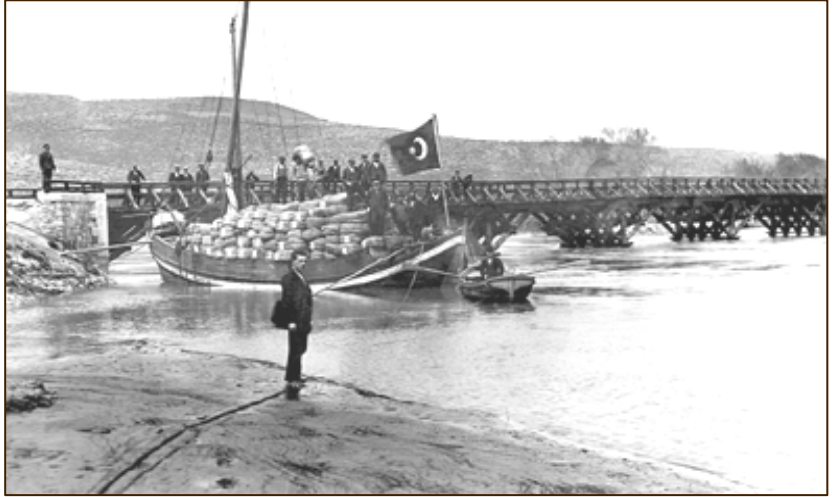
Foto 57: Taşlık köyü köprüsüne kadar işleyen tekneler (1930)
