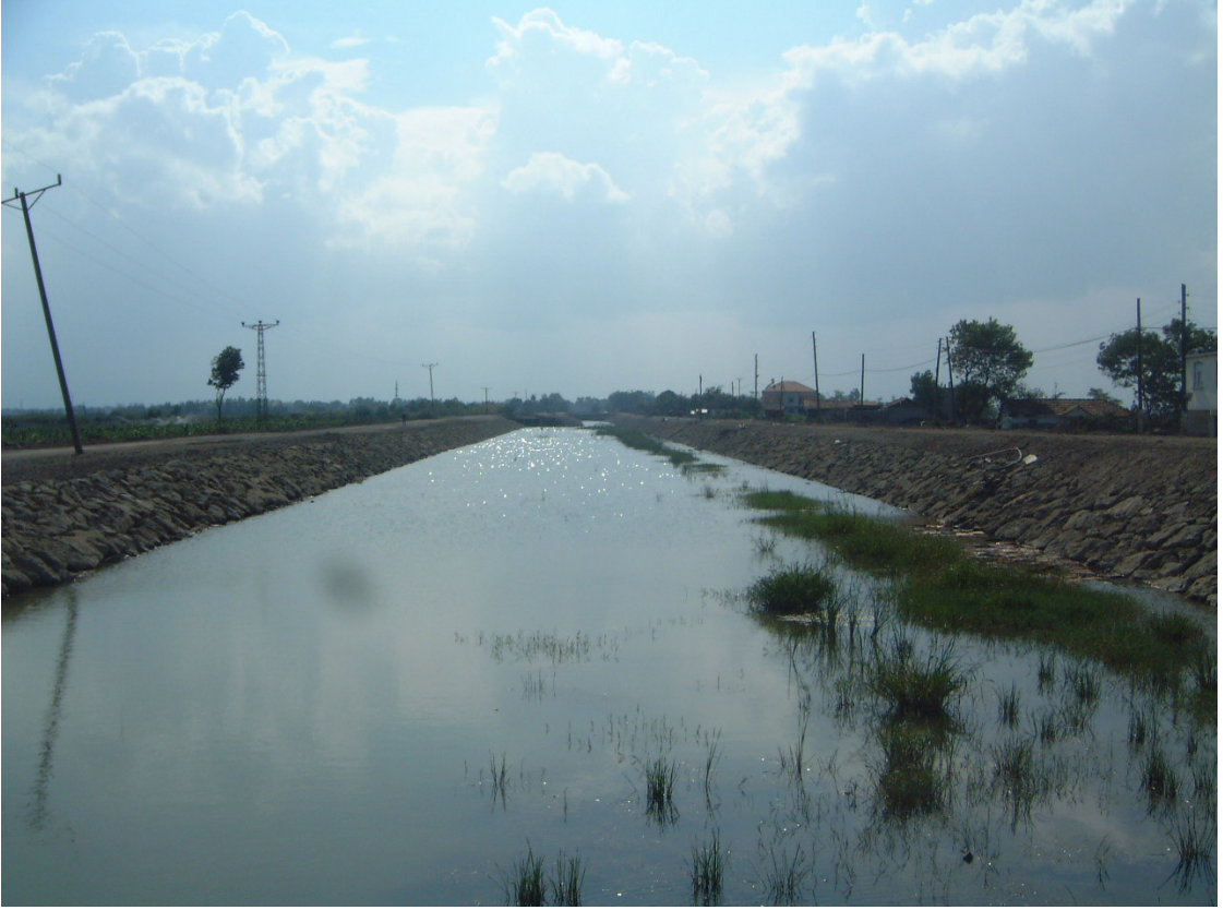
Őekil. 4. 1. Bafra Ovası Sađ Sahil Boytar Ana Drenaj Kanalı
