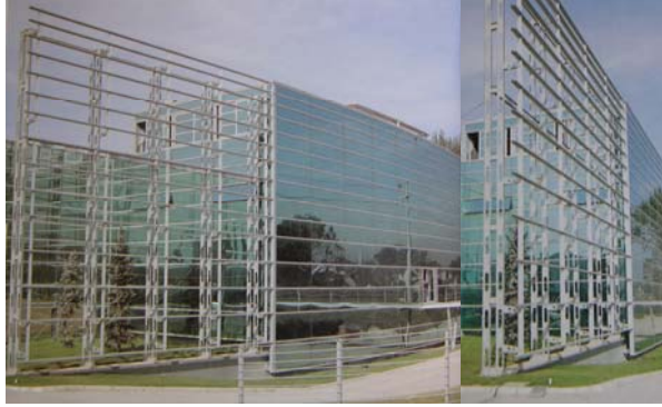
Resim 4.53. Aksoy-Technal Fabrika ve Yönetim Binası, Gökhan Avcıoğlu , İzmit [Avcıoğlu, 2001 }
