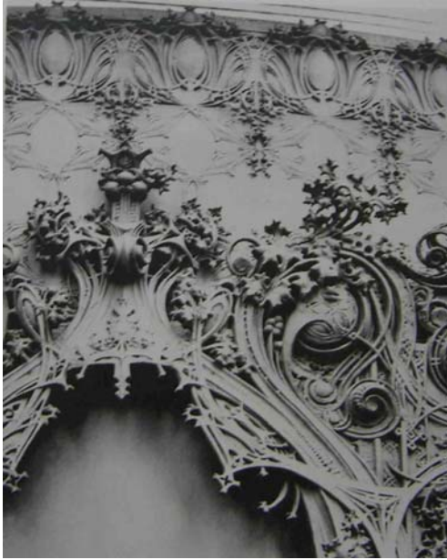
Resim 4.2. Schlesinger ve Meyer Mağazası, Louis Sullivan, Şikago, dökme demir süsleme, 1899-1904 [Trachtenberg ve Hymann,2001]
