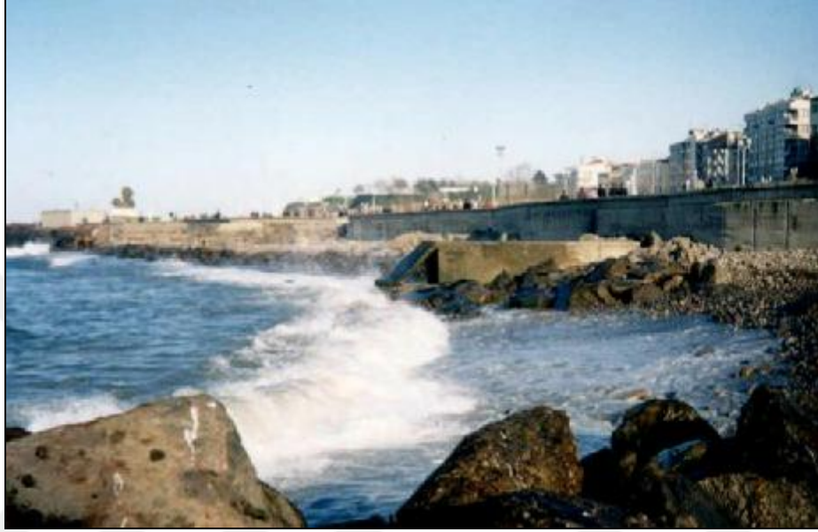
Şekil 2.1. Deniz kıyısına evsel atıksuyun kısa deşarjı (Trabzon)
