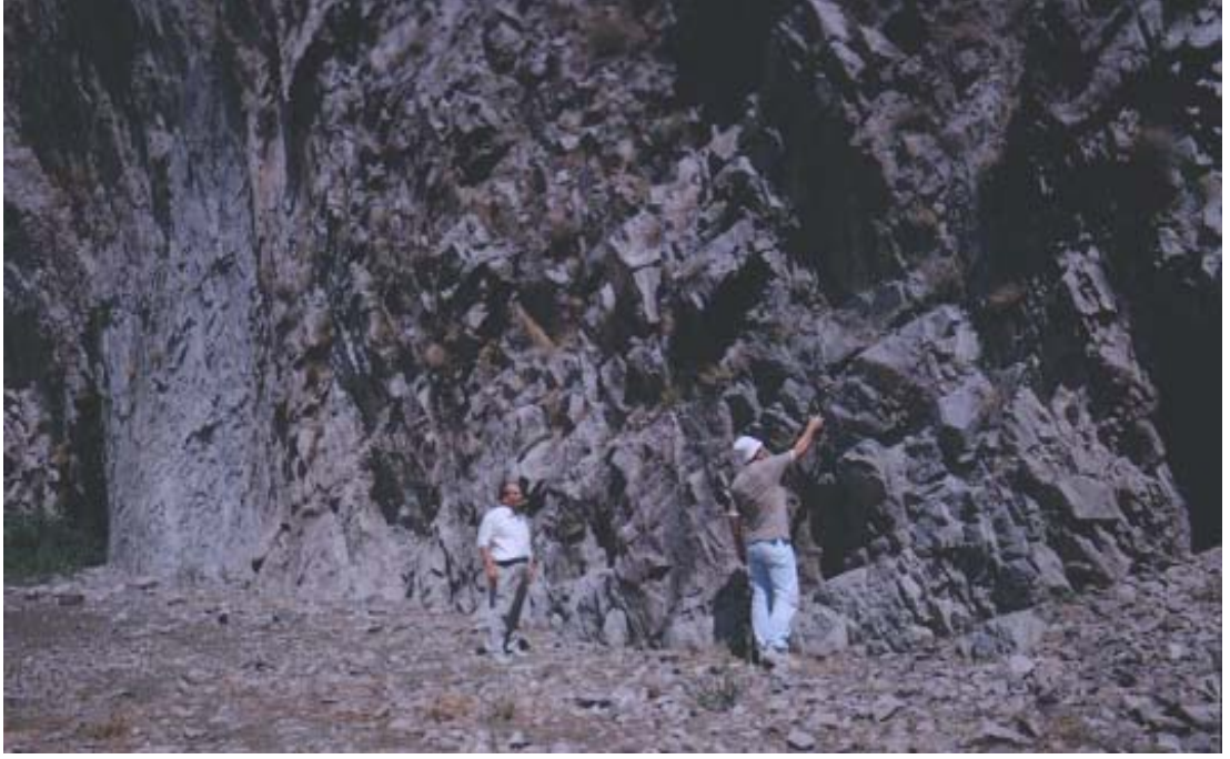
Şekil 2.17: Hasan kalesi batı yamacındaki andezitlerde gözlenen çok yönlü çatlak sistemlerinin görünüşü
