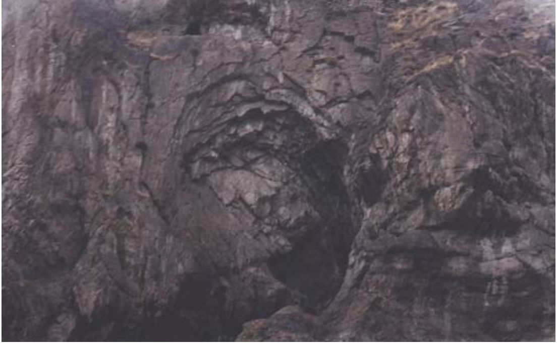
Şekil 2.19: Hasan kalesi güney yamacındaki andezitlerde ayrışma sonucu oluşan büyük boyuttaki, dairesel şekilli oyukların görünüşü
