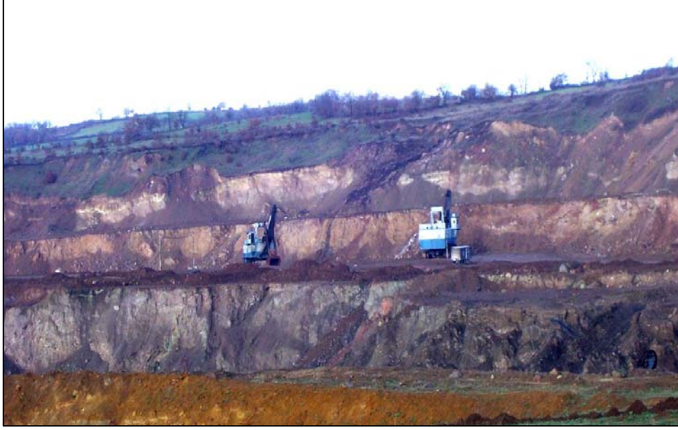
Şekil 3.3. Elektrikli ekskavatörlerin örtü kazı çalışması
