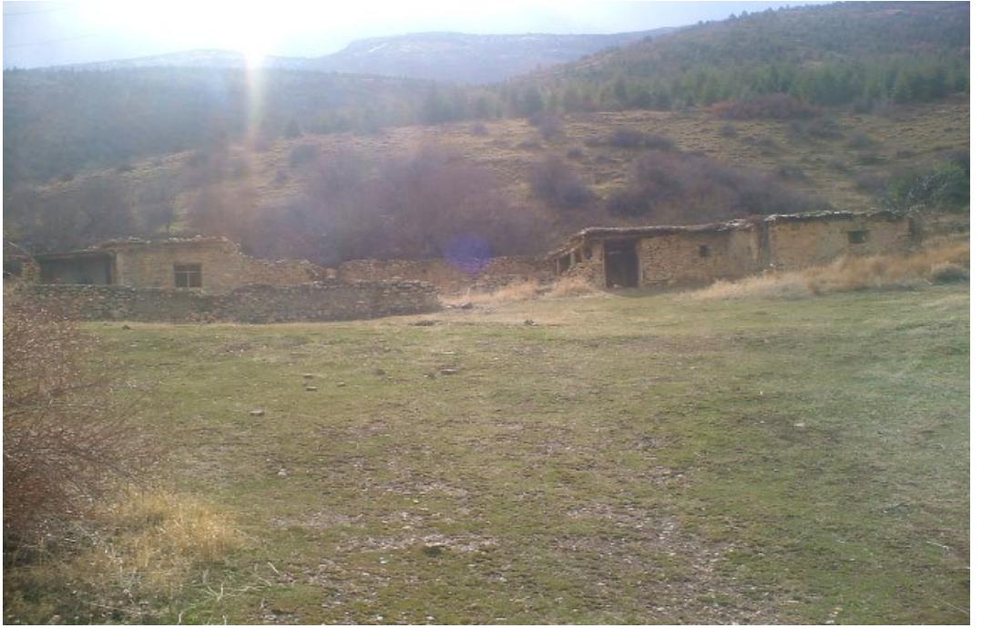
Foto. 20 : Sultandağları eteklerinde bulunan terkedilmiş bir ağıl yerleşmesi
