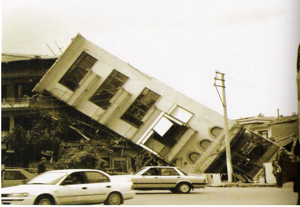
Şekil 2.1. 17 Ağustos 1999 depreminde yan yatmış 5 katlı bina (Çiftçi, 1999)
