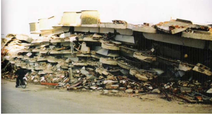
Şekil 2.13. Asmolen döşeme sonucu kat kat üst üste yığılmış konut binası (Çiftçi, 1999)
