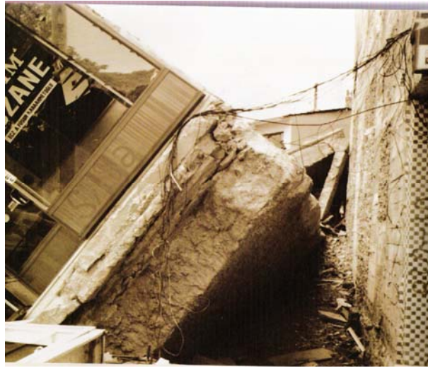
Şekil 2.2. 17 Ağustos 1999 depreminde yan yatmış 5 katlı binanın bodrum katı (Çiftçi, 1999)
