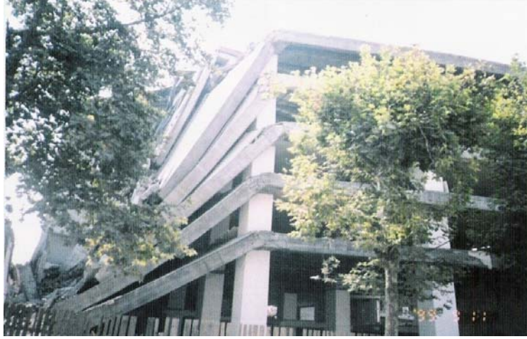
Şekil 2.16. Bina köşe noktasından almış olduğu hasar (Çiftçi, 1999)
