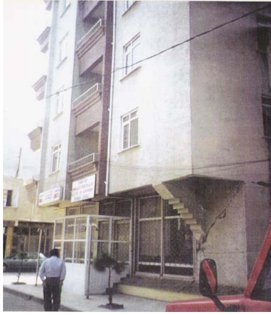
Şekil 2.4. Mimari süs için düşünülen gusenin binaya verdiği zarar (Çiftçi, 1999)
