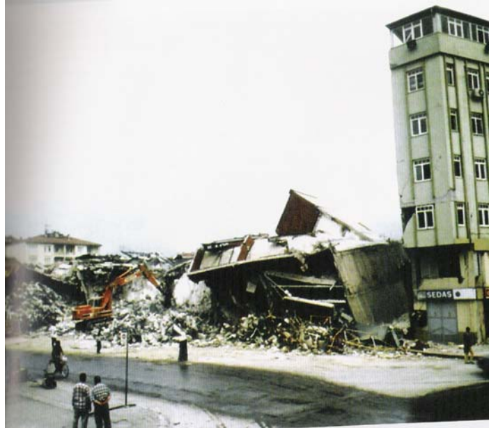
řekil 2.7. İř merkezi binasının depremden sonraki durumu (ifti, 1999)
