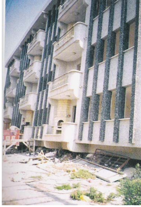
Şekil 2.10. Zemin katından hasar görmüş 5 katlı apartman (Çiftçi, 1999)
