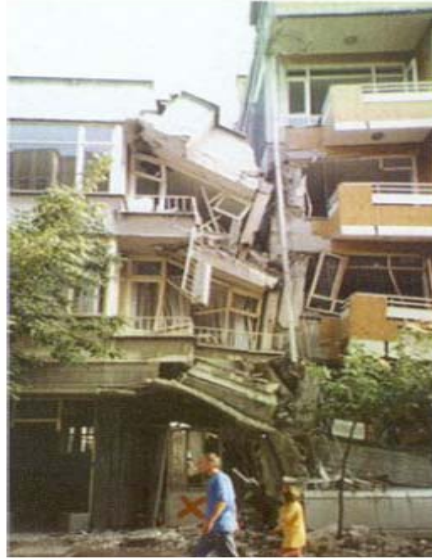
Şekil 2.25. Farklı yükseklikteki binaların çarpışması sonucu oluşan hasar (Balyemez ve Berköz, 2005)
