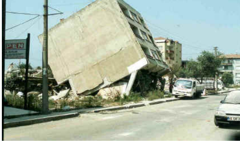
Şekil 2.17. Zemin katından almış olduğu hasar sonucu arkaya yatmış yapı (Darılmaz, 1999)
