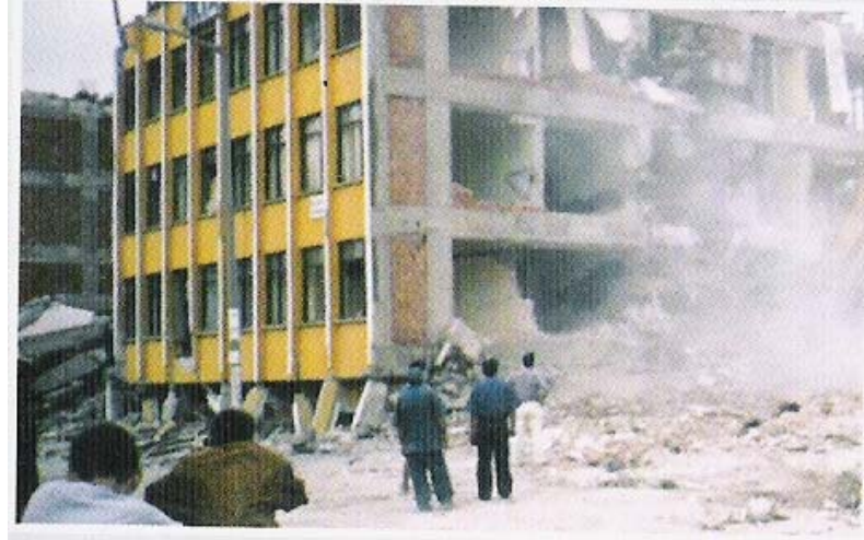
Şekil 2.9. Depremde zemin katından hasar görmüş bina (Çiftçi, 1999)
