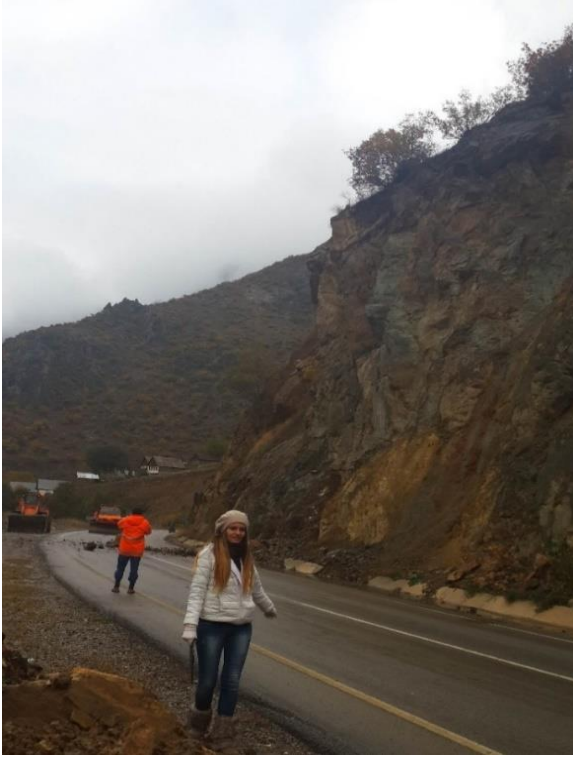
Şekil 2.10. Karayolu güzergahına şevlerden kopup düşen bloklar
