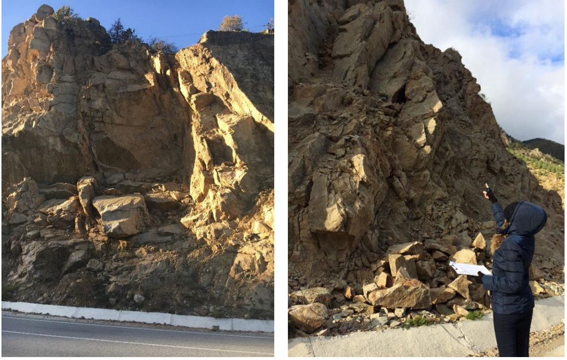
Şekil 2.14. Şevden kopup düşen blok görüntüleri
