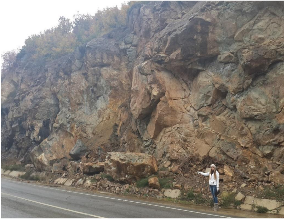
Şekil 2.11. Şev kenarlarında kopup düşmüş bloklar
