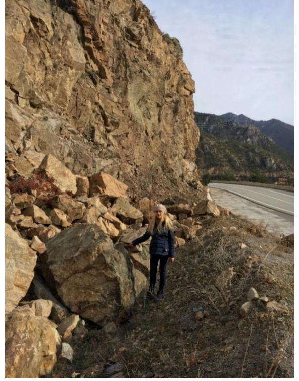
Şekil 2.10. Karayolu güzergahına şevlerden kopup düşen bloklar
