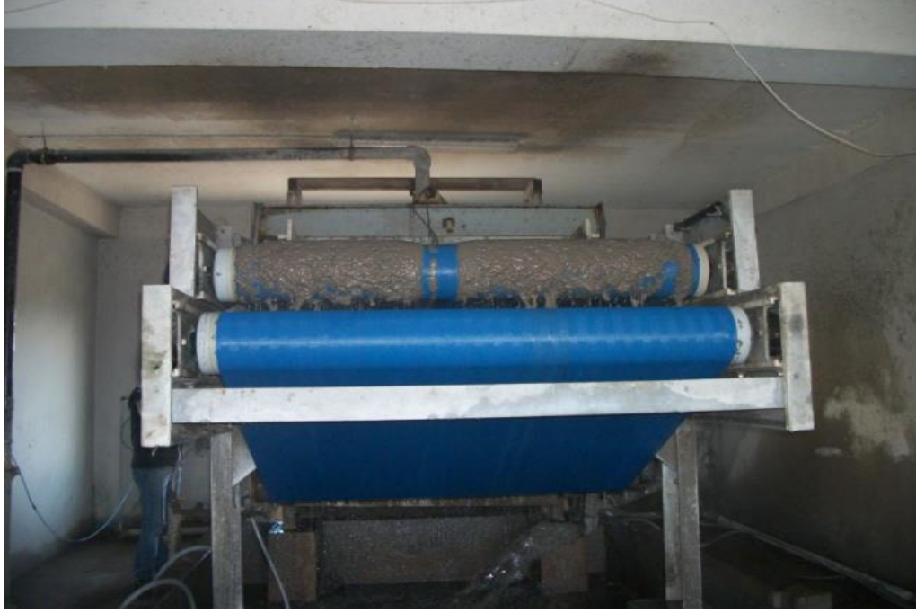
Şekil 1.5. Çamur susuzlaştırma ünitesi belt filtreler
