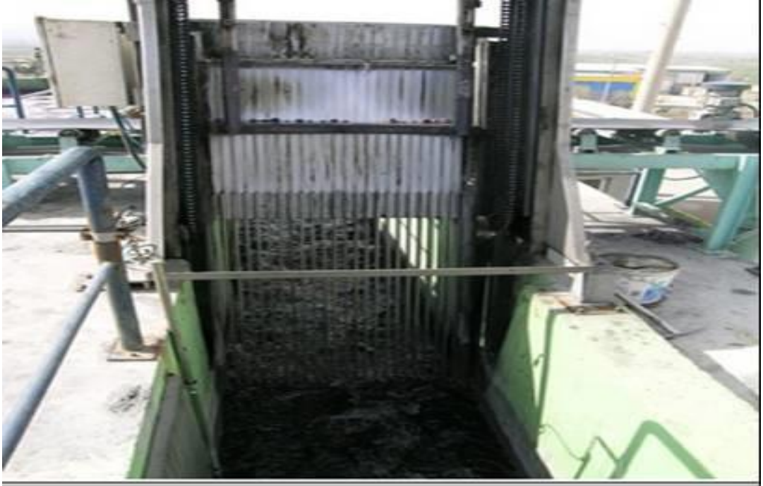
Şekil 1.2. Otomatik temizlemeli kaba ızgara
