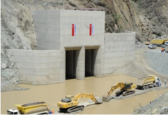
Şekil 1.13(a). Artvin Barajı deriv. tüneli
