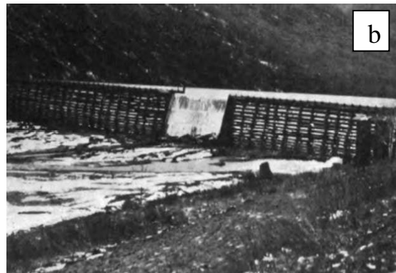
Şekil 1.25. Ahşap baraj örnekleri; Bir ahşap baraj örneği (a) ve Austin Barajı (b) (ABD)
