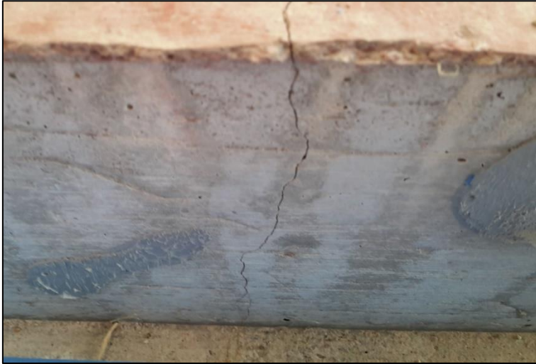
Şekil 1.3. Betonda oluşan çatlaklara bir örnek
