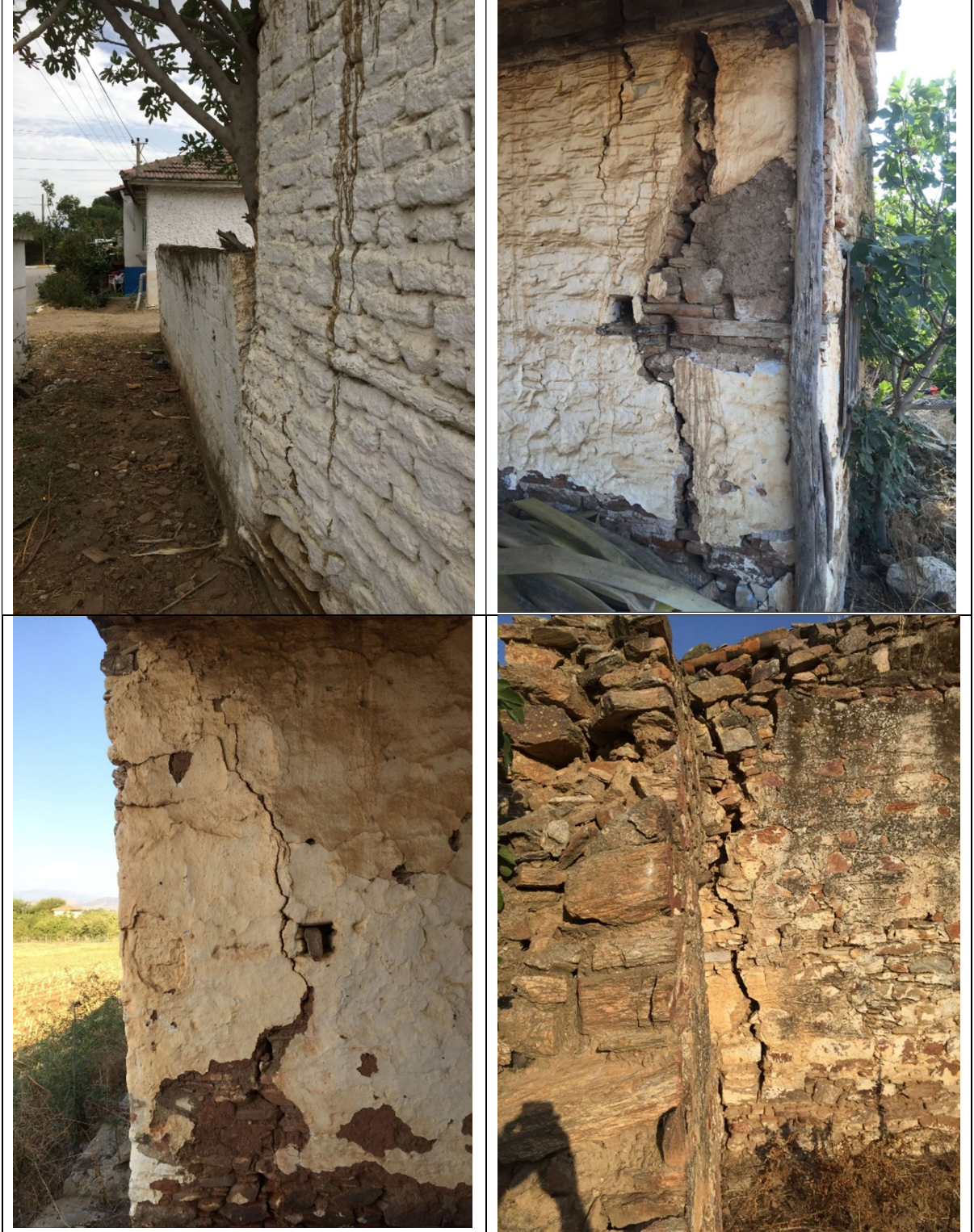
Şekil 4.20. Yolüstü Köyü (Ödemiş) civarında gözlemlenen taşörme-kerpiç evlerin duvarlarında oluşan çatlamlar
