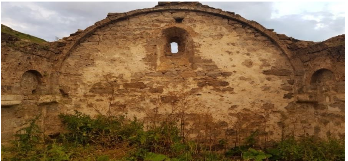
Şekil 3.60. Kızlar Manastırı'nın Tavan Kısım Günümüzde Büyük Ölçüde Çökmüş, Cephelerdeki İşlemeler Tahrip Edilmiş Durumdadır
