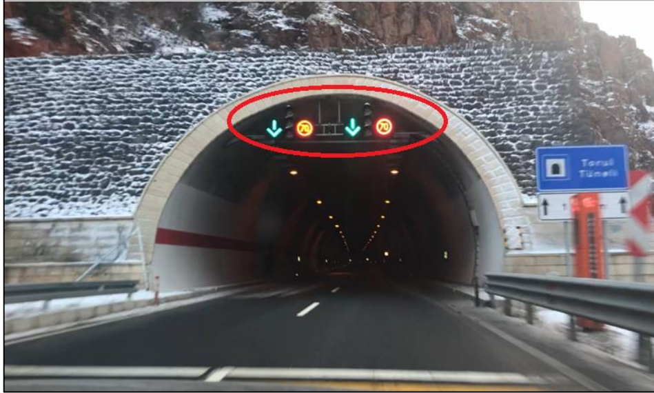
Şekil 1.13. Tünel kapatma ekipmanları (VTS)
