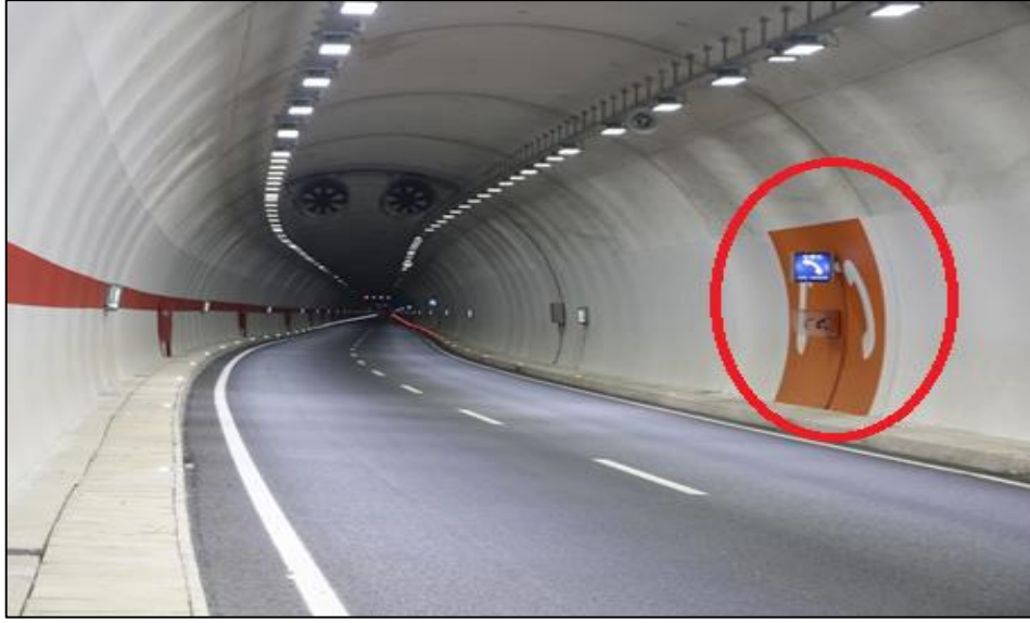
Şekil 1.22. Tünellerde kullanılan acil durum telefonları
