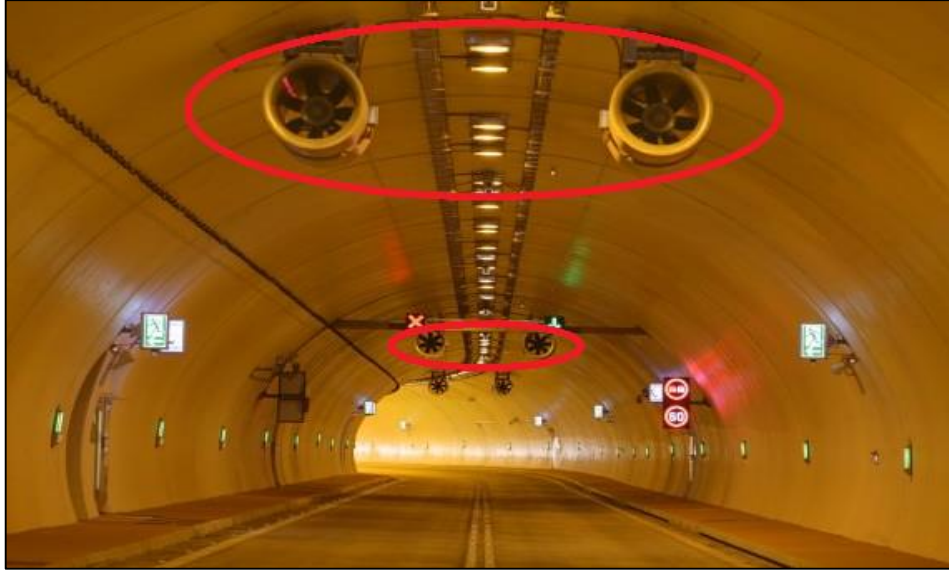
Şekil 1.19. Tünel havalandırma sistemi (URL-11, 2020).
