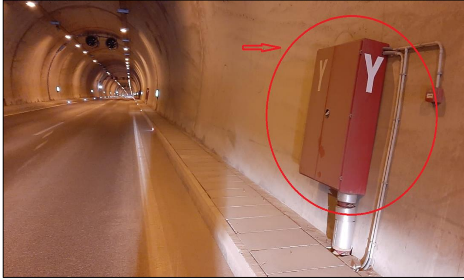
Şekil 1.23. Karayolu tüneline tefriş edilen yangın söndürme dolabı
