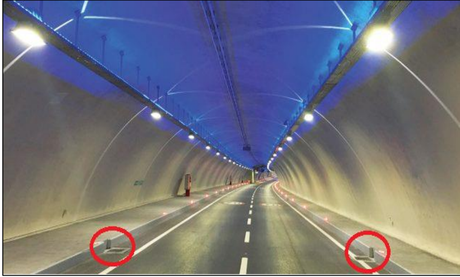
Şekil 1.6. Drenaj sistemi mazgalları (URL-9, 2020).
