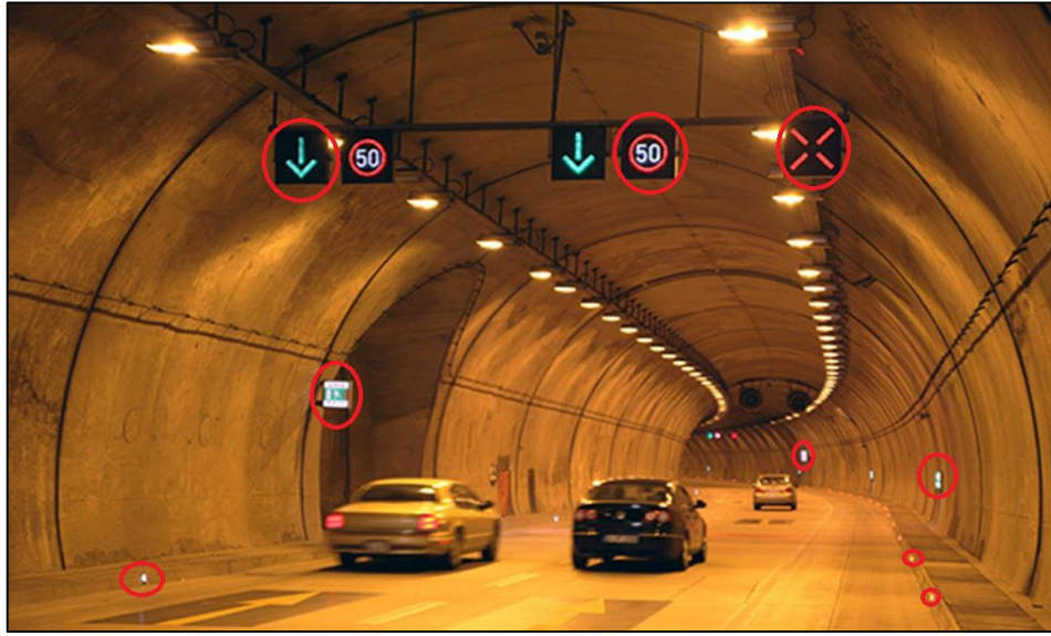
Şekil 1.21. Tünel içi işaretlemeler (URL-15, 2020).
