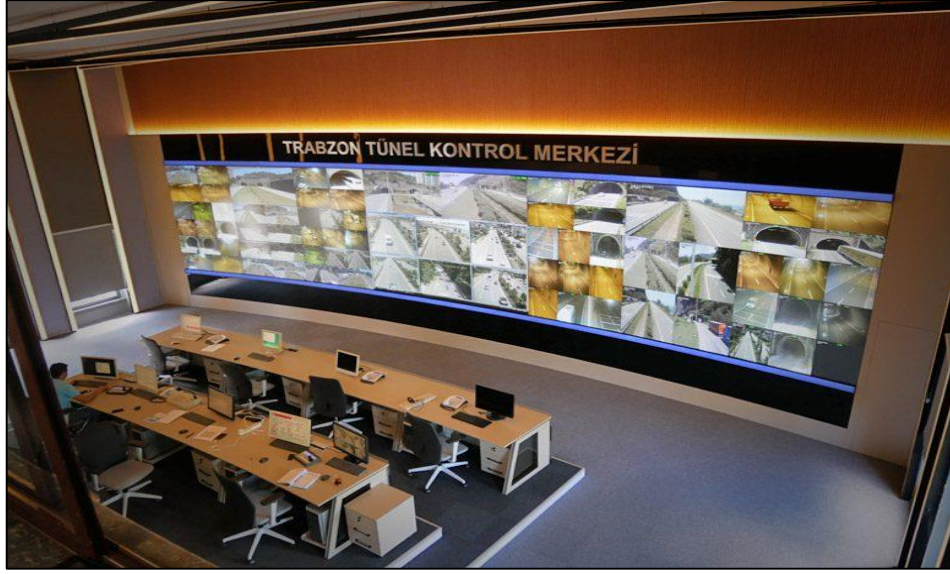
Şekil 1.24. Kapalı devre video izleme sistemleri (URL-16, 2020).
