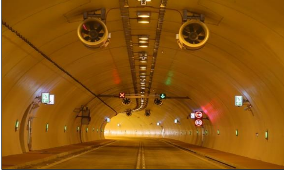
Şekil 1.8. Tünel boyuna havalandırması sistemi (URL-11, 2020).
