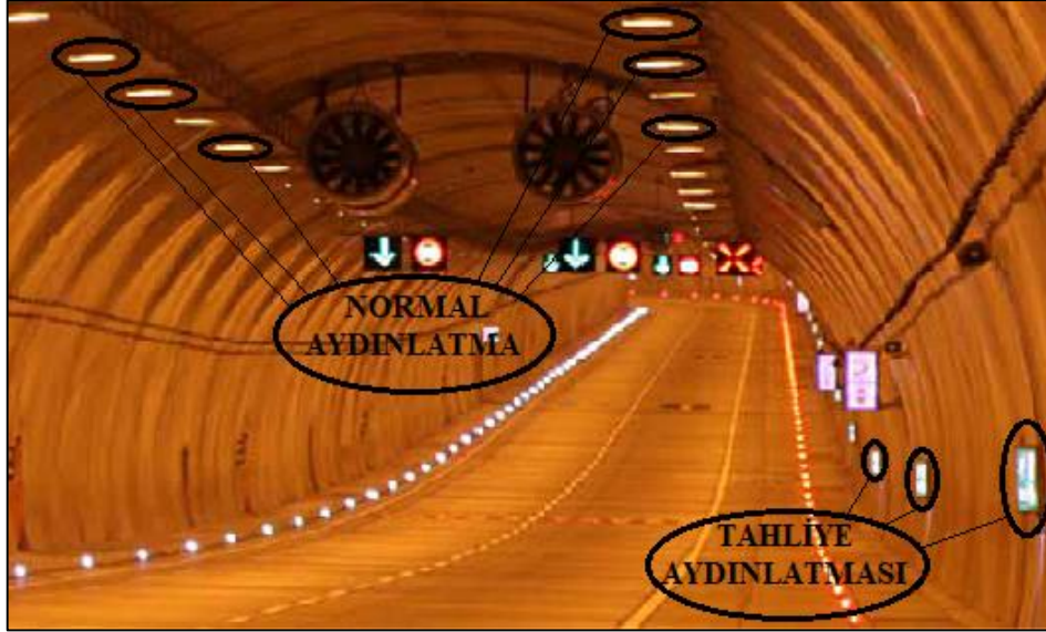
Şekil 1.7. Aydınlatma sistemi (normal ve tahliye aydınlatmaları) (URL-10, 2020).
