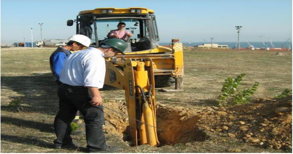
Şekil 1.4. Araştırma çukuru açılması
