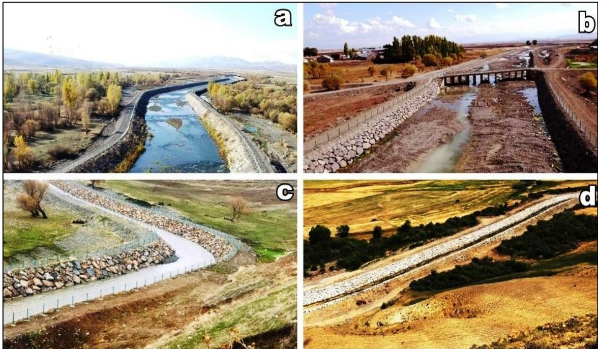
Şekil 1.17. Sedde ve istifli taş tahkimat ile taşkın koruma tesisleri Ağrı Eleşkirt Yücekapı (a), Ağrı Eleşkirt Değirmenoluğu (b), Erzurum Karayazı Çelikli (c), Erzurum Horasan Akçataş (d)
