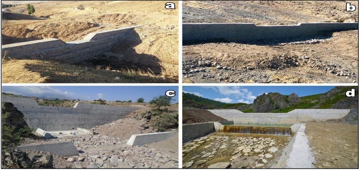
Şekil 1.15. Tersip bendi ile Ağrı Taşlıçay (a), Iğdır Halfeli (b), Kayseri Talas (c), Zonguldak Beycuma (d) bölgelerinde taşkın ve rusubat kontrolü
