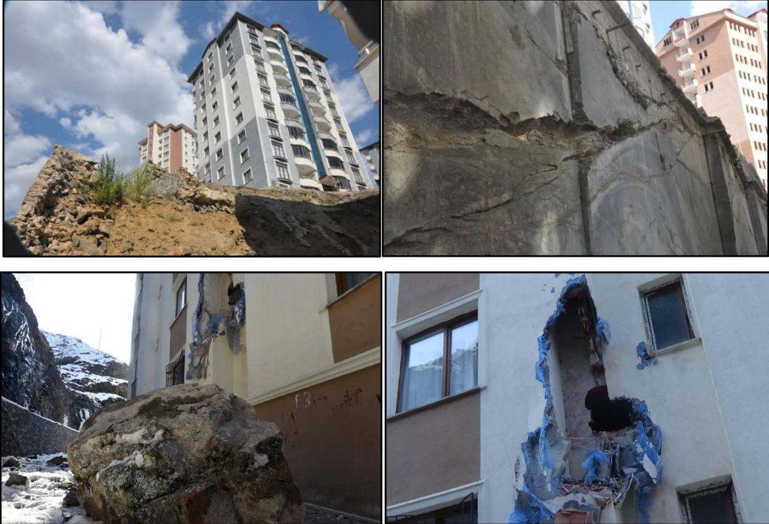
Şekil 3.11. Şev yüzeylerinden kopan andezit blokları (Oltanbey Mah. Aydınlık Evler ve Müze Evler Siteleri)
