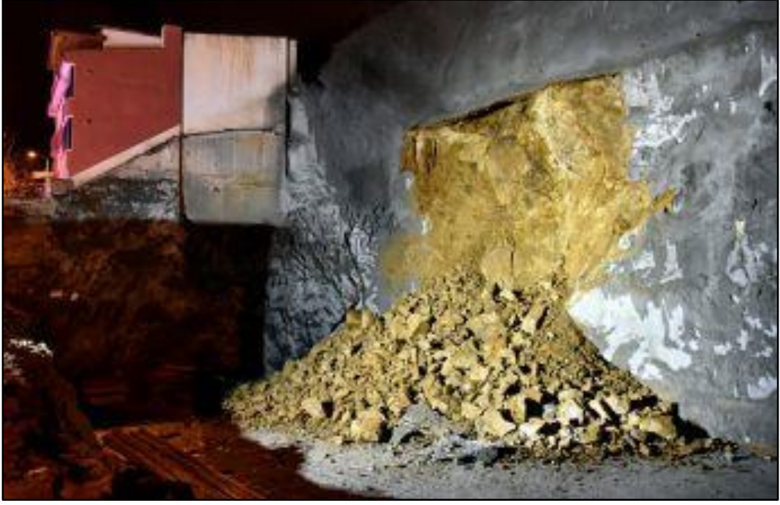
Şekil 3.14. Kesilmiş şevden kopan granit blokları (Karşıyaka Mahallesi)
